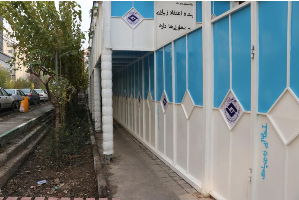
ساختمان جدید اتاق
