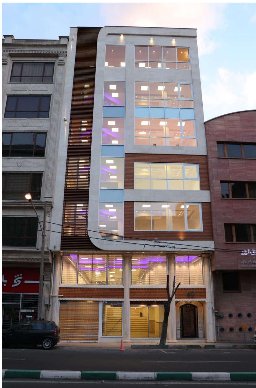
تکمیل پروژه ساختمان اتاق تعاون در خیابان خرمشهر
